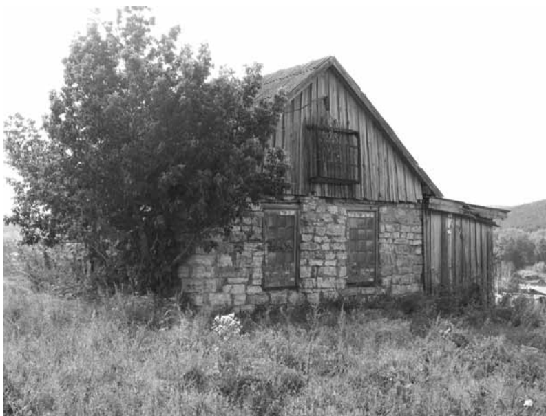
Подстанция бинасы. 2012 елдагы фото
